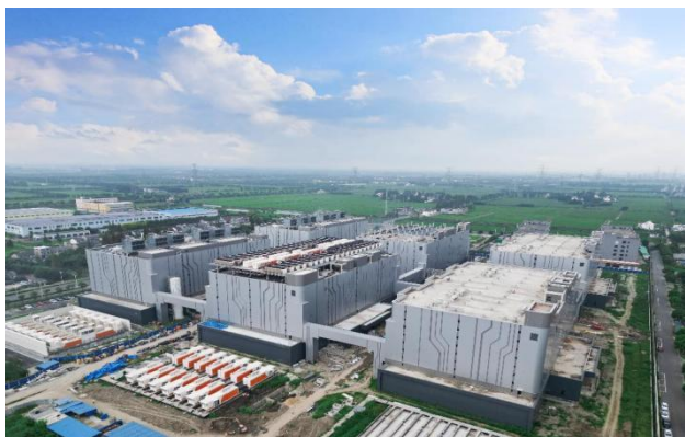
上海金山阿里巴巴数据中心项目
